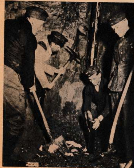
Mit Spitzhacken und Schaufeln im harten Gestein. Ein Artillerie-Unterstand entsteht.
